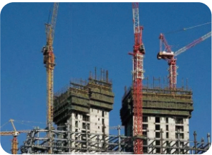
施工竣工测量
